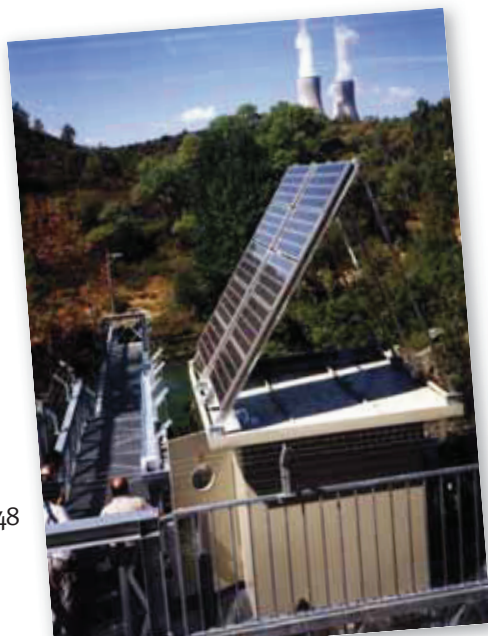
Instalación para un bombeo de la central nuclear de Trillo: “alimentábamos con una pequeña instalación fotovoltaica –cuenta Vaquero– un sistema de bombeo que tomaba muestras del río [foto]; como no querían llevar el cable hasta allí, porque les salía más caro, aquello se hizo con paneles solares”.
